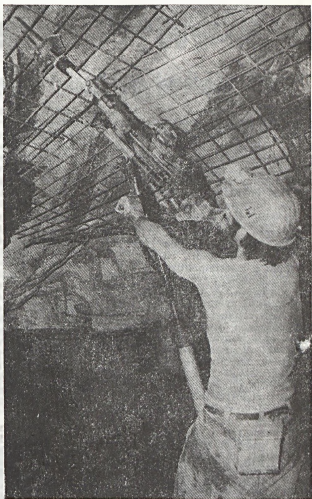
A képen Hódosi Ferenc vágja a főtészegecs beépítését végzi. Csöndör László felvétele
