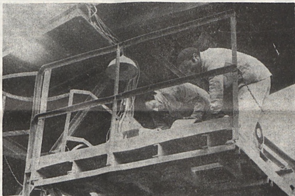
Fent a magasban is dolgoznak. A szállítószalag motorjának feszítőjét javítja Nagy Emil és Kovács Tibor, a József Attila szocialista brigád két tagja.
