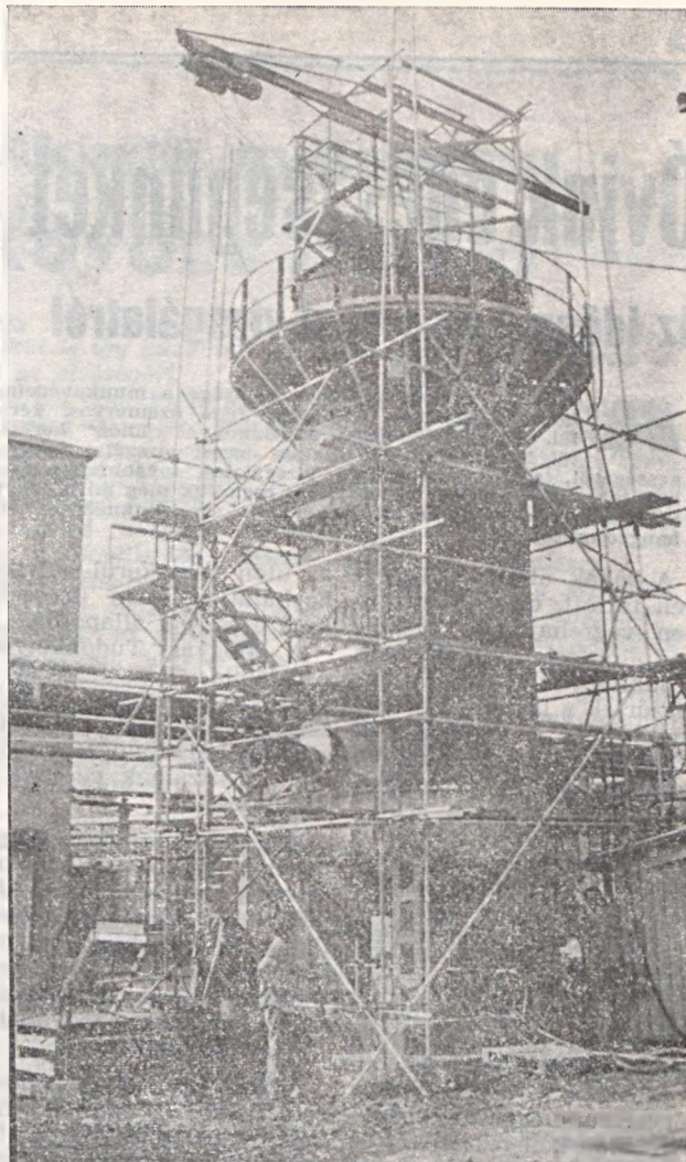
Felvételünkön a bauxit vastalanító oszlop szigetelési munkáit végzik a szakmunkások.
