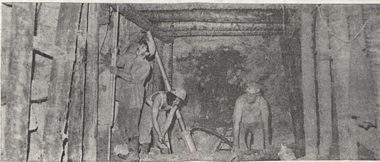
A IV. sz. bányászati 82-es lőjűségi brigádja ácsolás közben: Marton Tibor csapatvezető vágár, Huber László csillós, Schultz Marton vágár. Csöndör László felvétele
