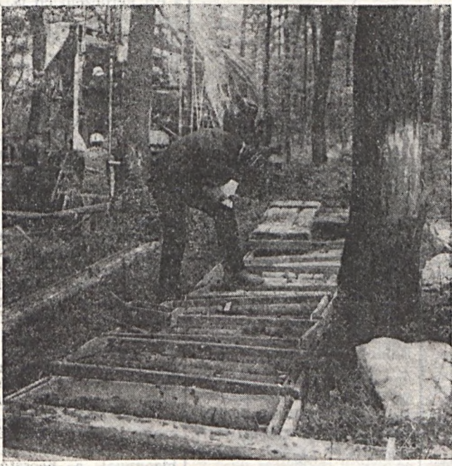
Szennyai Tibor geológus technikus az M—4-es berendezés fúrómagját dokumentálja, a háttérben Tóth Kálmán vezető fúrómester, Czako Lajos fúrómester és Eigner József fúrómunkás kiépítenek.
