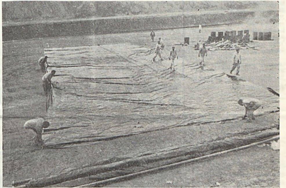
Készül a perkoláció III 11-es terének műanyagfóliás szigetelése.
