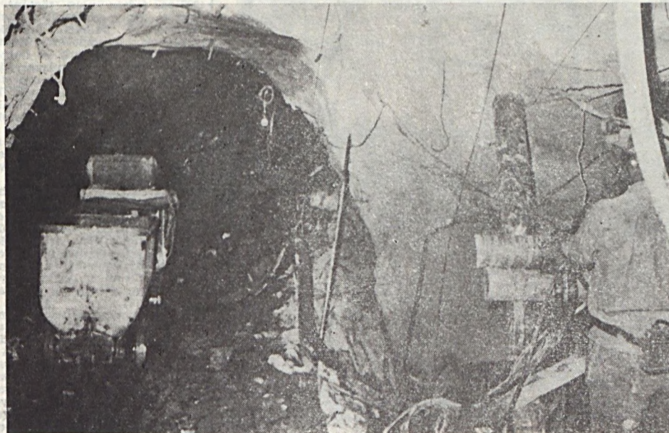
Távírányítású rakodógép dolgozik a IV. sz. bányáuzem hetedik szintjén. Csöndör László felvétele
