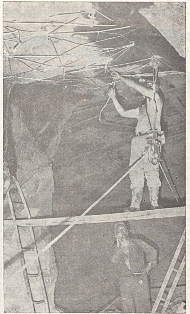
Kószó Zsigmond, a IV. sz. bányauzem fejlesztési részlegének dolgozója kísérleti jellegű főtébiztosítást készít polypropilén alapanyagú ipari kötélből. Csöndör László felvétele
