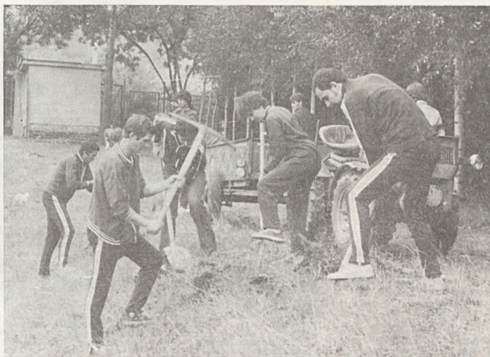
Folytatják a PMSC újmecsekfaljai sporttelepének felújítását. Vállalatunk KISZ-fiataljai közel 300 óra társadalmi munkával segítették a keleti lelátó építését. Képeken az EDÜ kiszelei munka közben.
