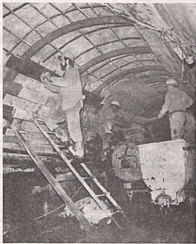
Alapvágat korszerű biztosítási munkálatait végzik a IV. sz. bányauzem 5. szintjén
