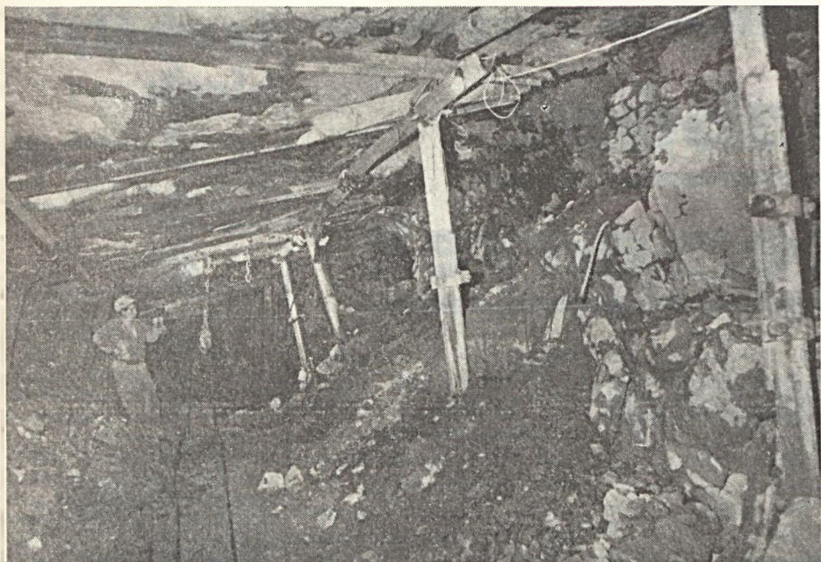
A tömbfejtés tölcserkamrájának biztosítása a IV. sz. bányaiüzem 53-as csapatán Csünder László felvétele
