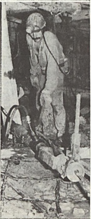
Fülöp Sándor omlasztóvájár a csökkentett méretű elektrohidraulikus fémtám-rabló berendezéssel dolgozik
