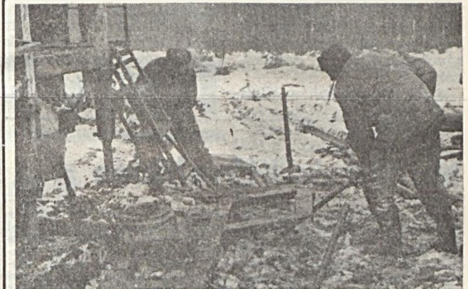
A lecsavaró és a géptalp szerelése
