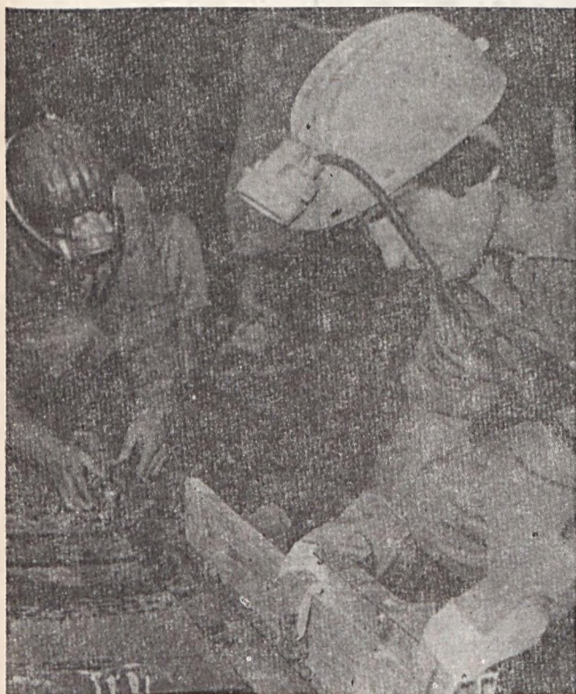
Vasút beépítés főszállító vágatba
