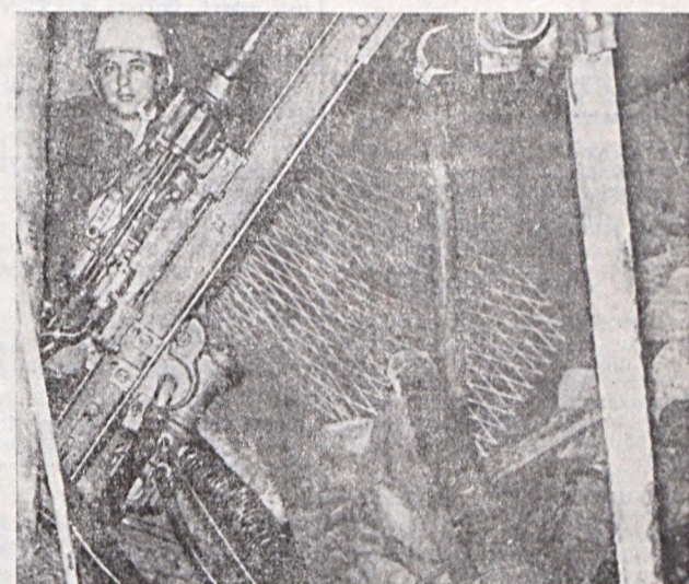
A TP-3000-es fúrógép szerelése magazin fejtésben
