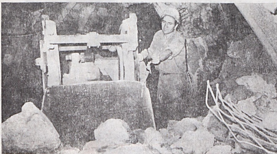
Sűrítetlevegős közetrakodógéppel Oláh János csapatvezető dolgozik.
