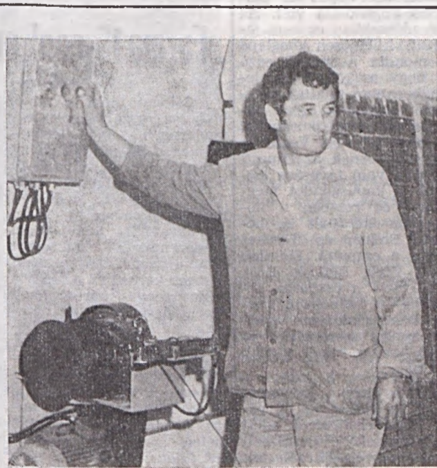
Ez is egy ésszerű újítás, melyet az EDU ventilátor házában szereltek fel a szűrőkeretek könnyebb mozgathatósága céljából. A berendezés Böngyik Péter és Kramasza Sándor újítása. Képiükön Böngyik Péter, Keller Gábor felvétele
