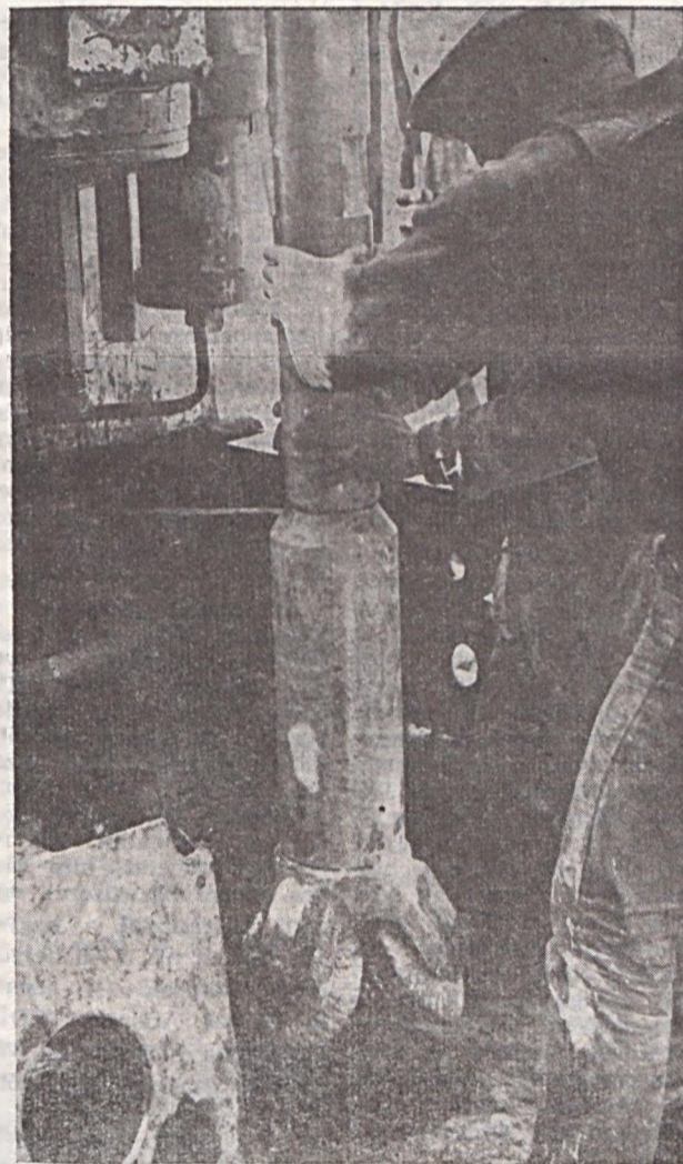
Nagy átmérőjű görgős fúró beépítése a mélyülő vízkútba. Tér István felvétele
