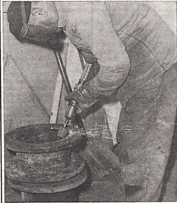
Bozó Zoltán gumizás előtti csőszakaszt készít elő.
