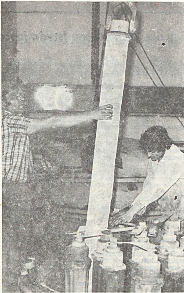
Munkában az EDÜ „druck” szűrő szerelői, Pásztai Gábor és Frank Sándor, akik a meghibásodott szűrőoszlopokat cserélik ki. Az ő munkájuk elengedhetetlenül szükséges a folyamatos üzemeléshez.
