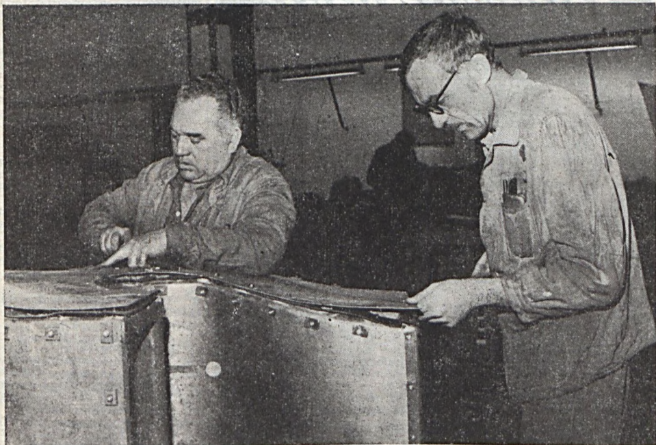
A IV. sz. bányában folyik a zajártalom elleni küzdelem. A képen látható zajcsökkentő dobot a bányában elhelyezett hűtőgépre készíti Szili Mihály és Csöndör László felvétele
