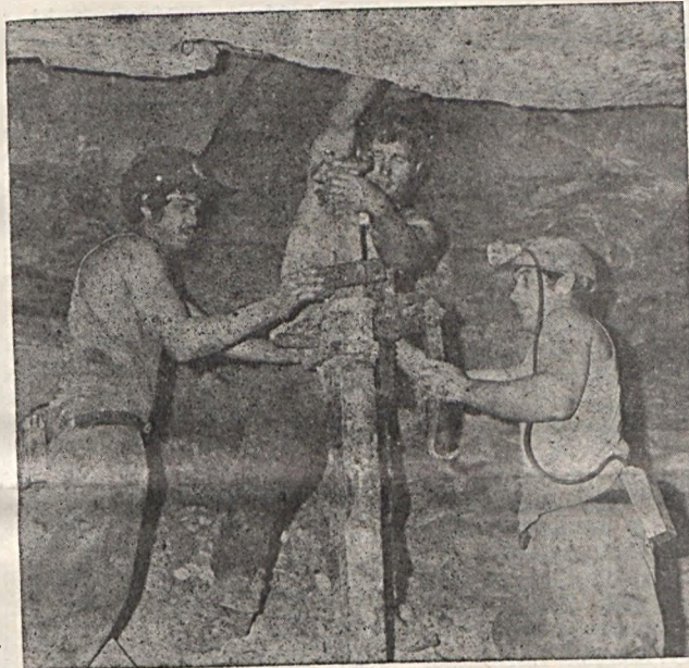
Felvételeinkön balról jobbra: Kovács László, Faragó Imre és Henez Béla a 41-es csapat tagjai fémtámbeállítását végzik. Kiss László felvétele
