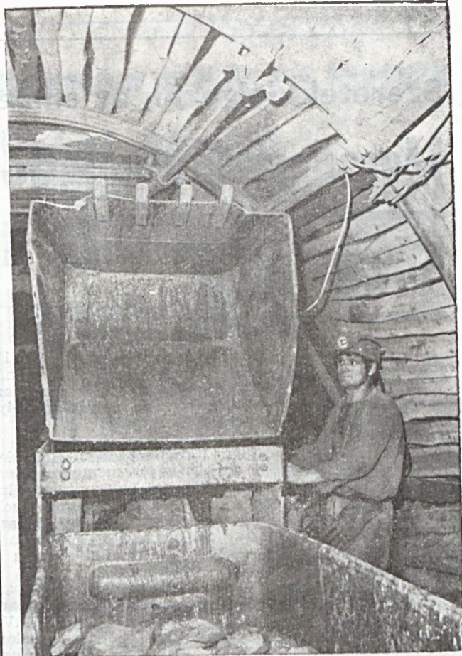
Köztefelrakás duplaszelvényű vágat jobb oldalán. A munkát a II. sz. bányüzem 20. szintjén Kiss György István szakvezető vágja végzi. Keller Gábor felvétele
