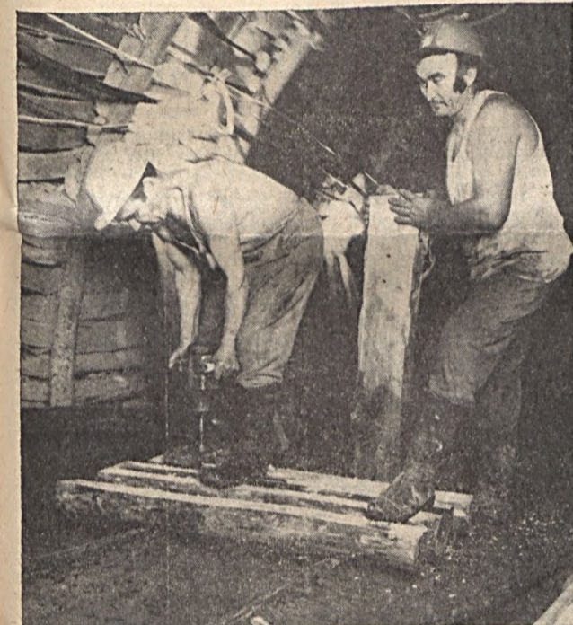
Vasútépítők a föld alatt. A nyugdíj előtt álló Turbuk András (októberben megy nyugdíjba), aki húsz évet vājvégen dolgozott és jelenleg is aktív szakvezető vājárként dolgozik, Erdélyi István segítségével — aki mögött szintén húsz év föld alatti munka van — építik a vasutat.
