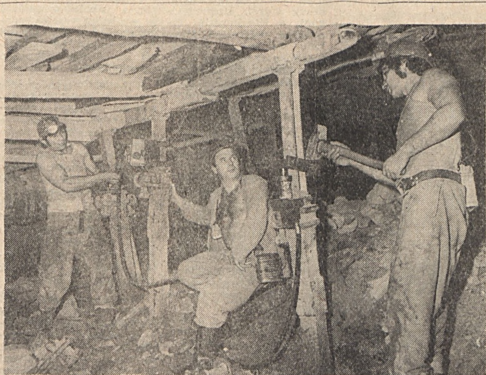
A fizikai munka könnyítését szolgálja az olajhidraulikus támfesztő. Felvételünk a II. sz. bányauzem 18-as csapatánál készült. A fesztést Kovács Imre és Czákó István végzik, középen Berecz István körletvezető-helyettes.
