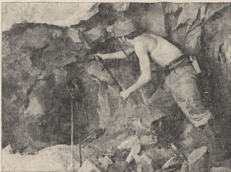
Alapvető biztonsági előírás az úgynevezett kopogózás, melyet képzünk a II. sz. bányüzem 70-es csapatának szakvezető vájára, Schönviessner Gyula végzi.
