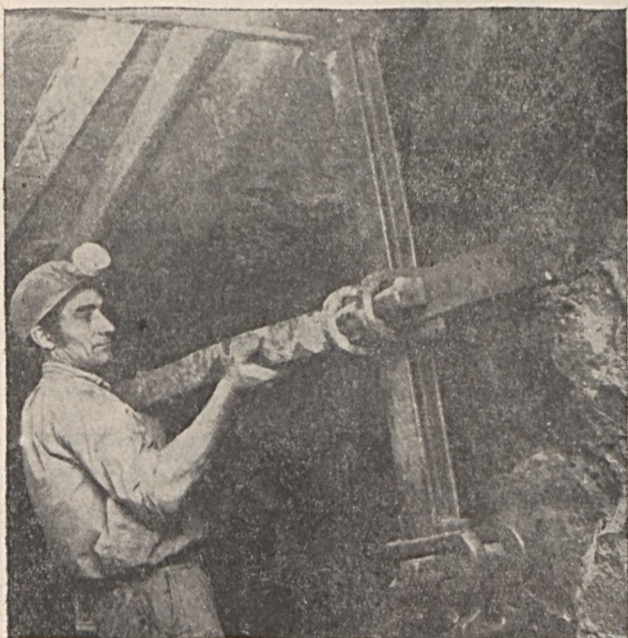
Szabó József csapatvezető-vájár az ideiglenes biztosítás leszerelését végzi a III. sz. bányáüzem 3-as körletének munkahelyén.
