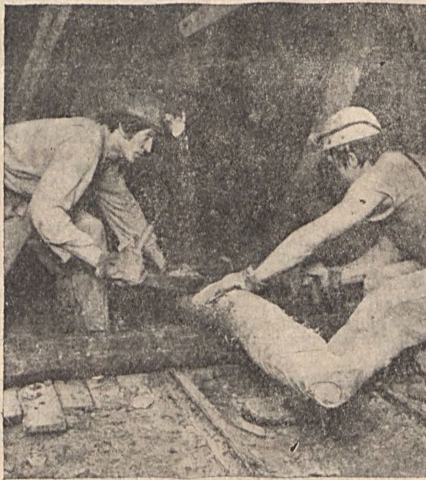
A III. sz. bányüzem 50-es szocialista brigád két tagja keretfát készít elő a vágaton. Keller Gábor felvétele
