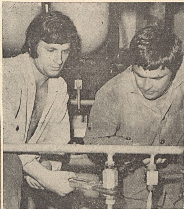
Solya József és Ravadies Mihály az olajhidraulikus berendezés visszacsapó szelepeit ellenőrzi az EDÜ-ben.
