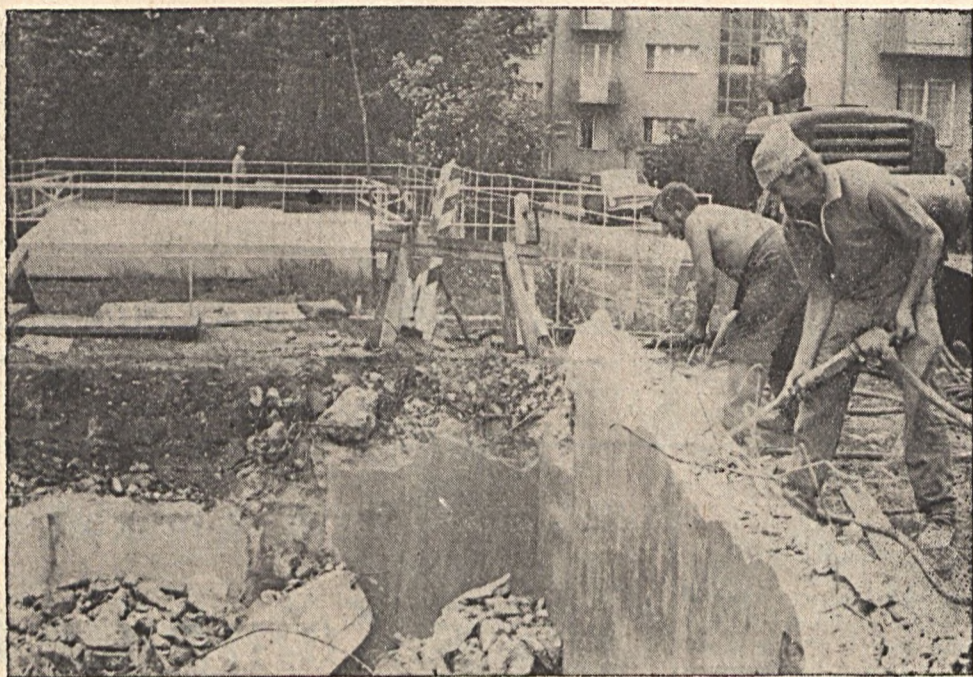
Már az új gáznyomás-szabályozó berendezés működik a Kőrösi Csoma Sándor utcában. A régít a Gázművek dolgozói lebontják és betemetik, hogy ne rontsa a városképet. Keller Gábor felvétele
