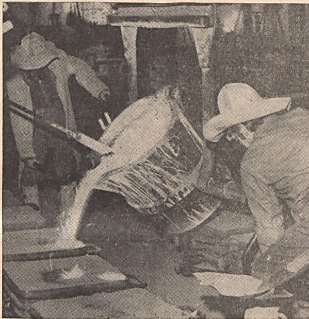
A Szolgáltató üzem öntödéjében formákba öntik az izzó acélt. Keller Gábor felvétele
