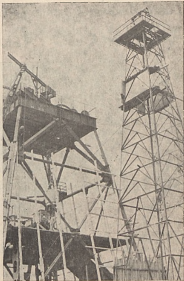
Az aknamélyítő torony szomszédságában ismét áll a mélyfúró torony, az épülő V. sz. bányauzemben. Az építés helyzetéről képriportban a 3. oldalon tájékoztatjuk olvasóinkat. Keller Gábor felvétele
