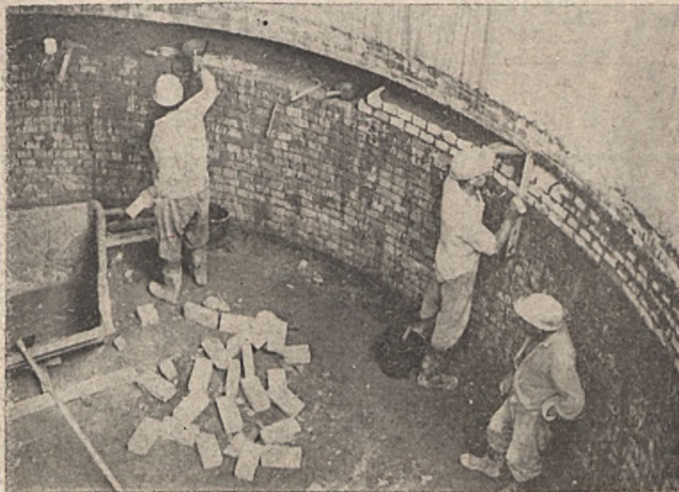
Épül az V. sz. bányauzem
