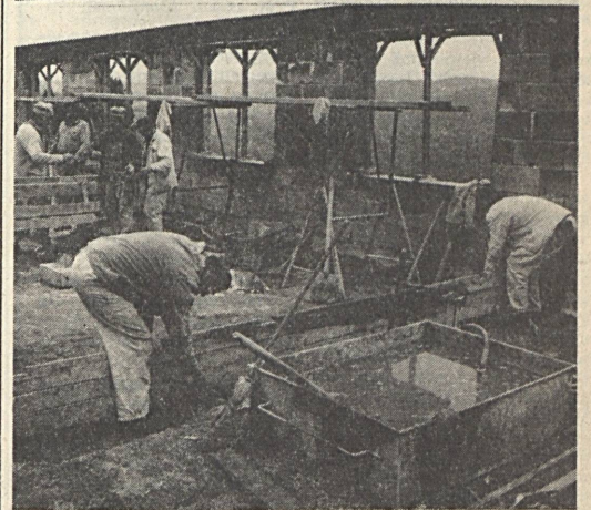
A zobáki irodaépület emeletráépítési munkálatait az Építési Üzem dolgozói végzik. Fotó: Tóth László
