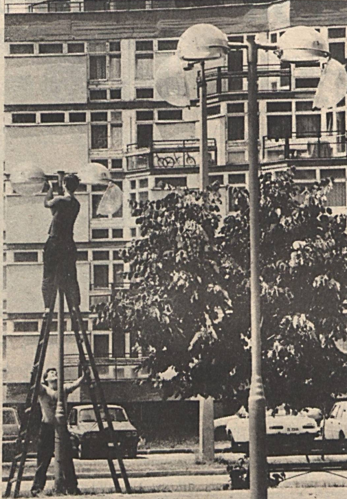
A DEDÁSZ komló kirendeltségének dolgozói megtisztították a Színház- és Hangversenyterem előtti tér nátrium-lámpatestjeit, s kicserélték a meghibásodott égőket.
