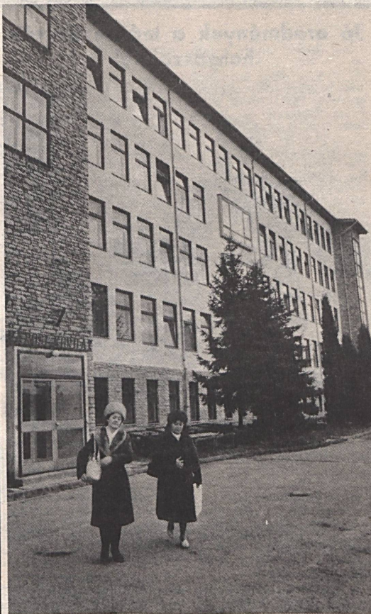
A komlói kórház felújított homlokzata
