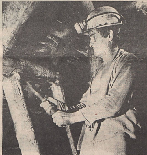
A Komló Bányauzemben több fejtési munkahelyen még hagyományos technológiával készült a biztosítás. Képünkön az egyik zóbai vájár éppen az ácsolat összeállításán dolgozik.
