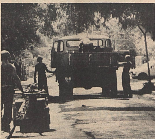
A „meszei földgáz-program” első ütemében befejeződött a csövezetési és a Balassi Bálint utcában és már végzik is az aszfaltozással történő nyomvonal helyreállítását a Köztisztasági és Utkarbantartó Vállalat szakemberei. (Tóth L. felv.)
