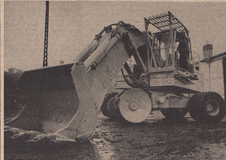
A műszaki fejlesztési program részeként a Külfejtési Üzem újabb Broyt kotrógép érkezett, amely a napokban áll munkába az üzem vasasi munkahelyén. Képünkön a gép kezelő ismerkednek az összeszerelés alatt álló berendezéssel. (Riportunk a 3. oldalon) Fotó: Tóth L.
