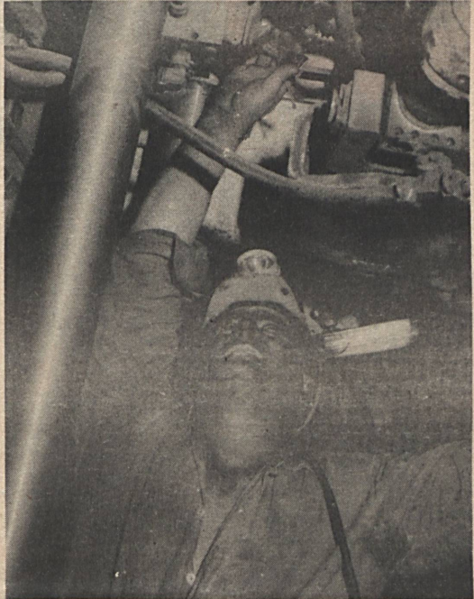
A Mecseki Szénbányáknál az utóbbi években nagy gondot fordítanak a biztonság növelésére. Ezt jellemzi a Mecsek Dowty-pajzs kifejlesztése és alkalmazása is. Képünkön Sós Pál Zobákbányán lépteti a Dowty Mecsek-pajzst. Fotó: Nemesi Árpád
