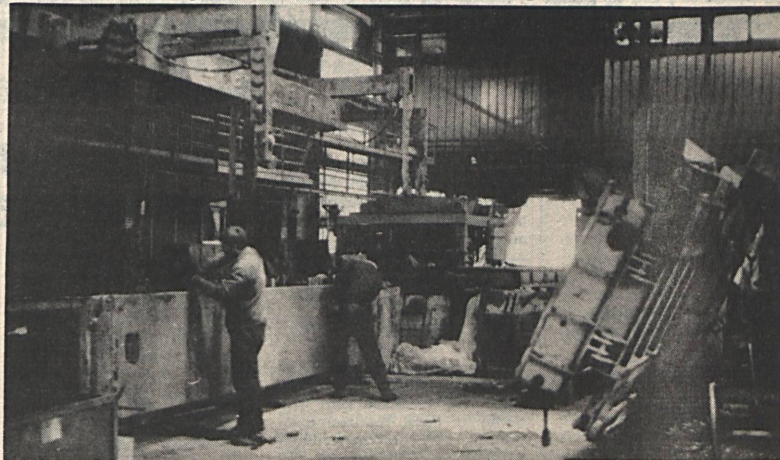
A Beton- és Vasbetonipari Művek Komló gyártelepén állítják elő a középületek építéséhez nélkülözhetetlen UNIVAZ-falpanelt. Kóródi Gábor felvétele ezen épületelemek gyártását örökítette meg.
