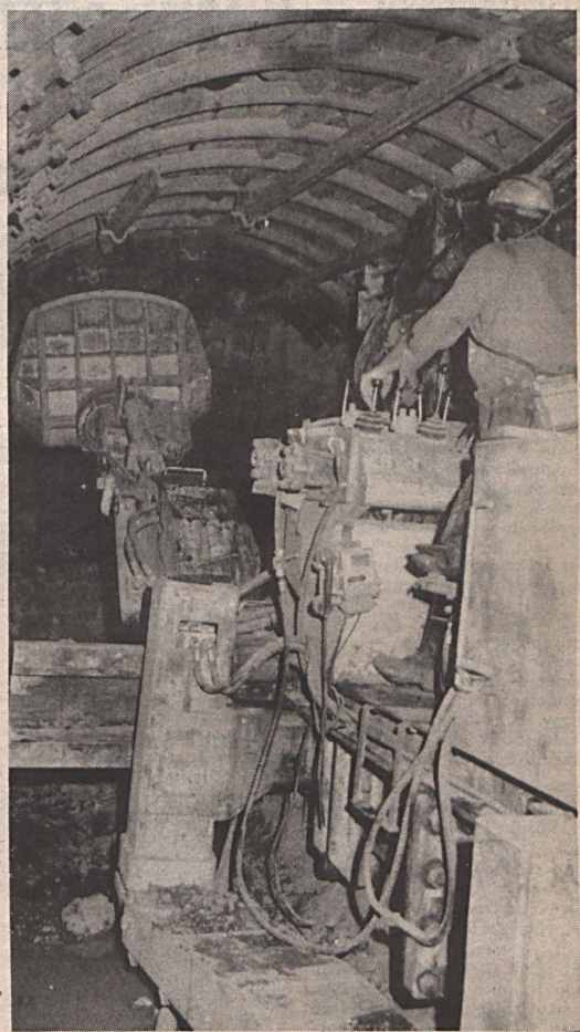
A Mecseki Szénbányák műszaki fejlesztési programjában több hazai és külföldi gépegység honosítása, alkalmazása szerepel. Képfőnkön a Zobák-aknán működő vágathajtó gépser: a PERARD.
