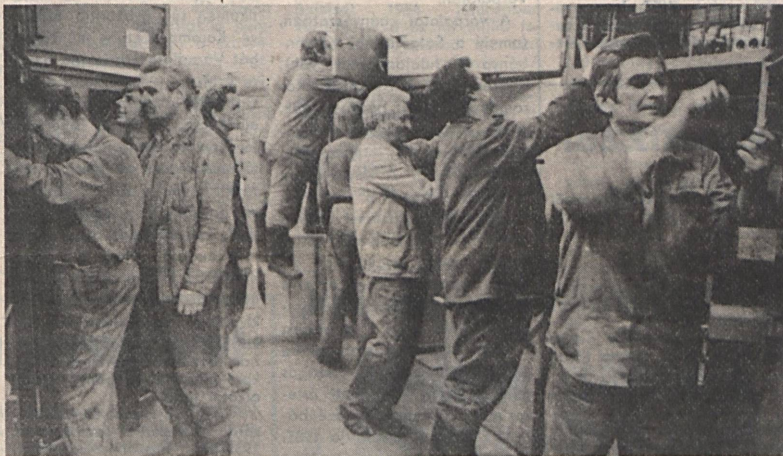
A Mecseki Szénbányák Villamos Üzeme Bétán, a 6/04 kilovolttos állomás rekonstrukcióját végzi. Képünkön a Gagarin nevet viselő szocialista brigád a kapcsolótérben végzi a felújítási munkálatokat. Fotó: Kóródi
