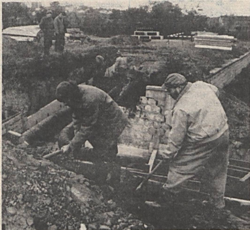
A távfűtő művek szakemberei csöveteket szerelnek Szilvásbán. Fotó: Kóródi Gábor
