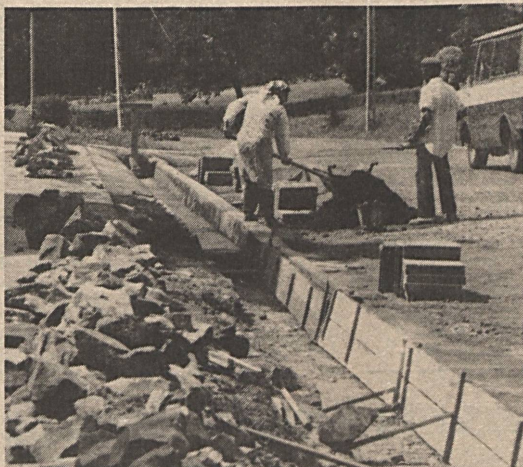
Komlón, a Kölségyvetési Üzem szakemberei a tél által okozott fagyáskárok kijávitásán dolgoznak. Képünkön a KBSK sportpálya vezető út mentén, a csapadék vízelvezető csatornákat újítják fel.
