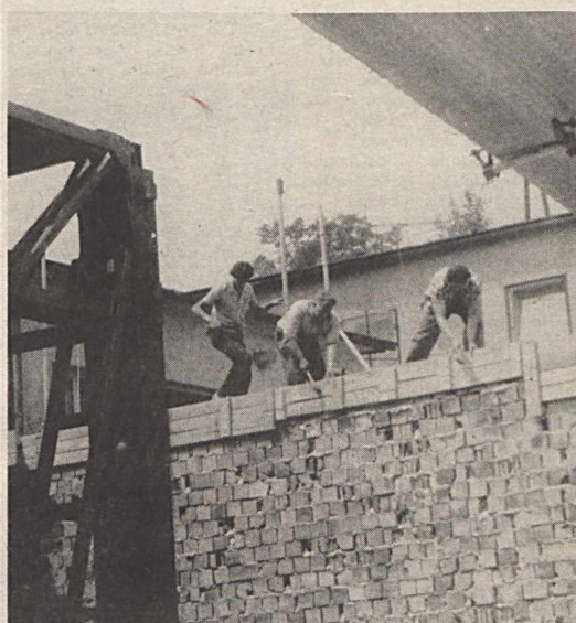
Carbon: a konfekcióüzem fejlesztése saját beruházásból. Képünkön Bérczes János és brigádja a betoncoszorú szaluzását végzi.
