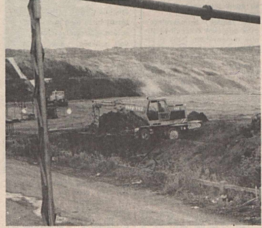
A DOOR-ülepítőkád helyének az előkészítése látható felvételen. A munkálatok során több ezer köbméter salakot kellett elszállítani a salakhegyből. Fotó: Kóródi
