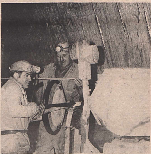
Kossuth IV-es akna V. szintjének végleges kialakításánál Auth János csoportvezető és Ludán György lakatos betonkeverőt helyez üzembe. Fotó: Beck Péter
