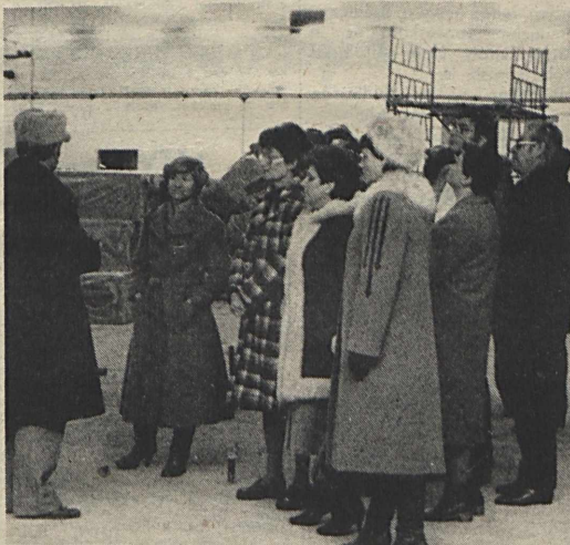
Az épülő új komló kényergyárban Bencze László üzemvezető tájékoztatóját hallgatják az párt-végrehajtóbizottságának tagjai. Fotó: Kóródi G.
