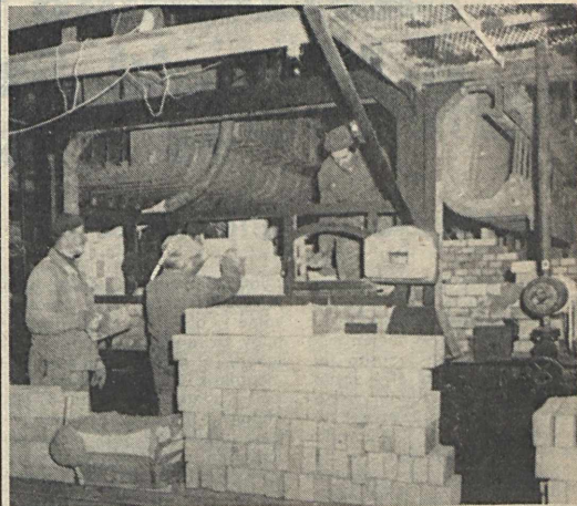
A budapesti Hőtechnikai Vállalat pécsi kirendeltségének szakemberei újítják fel Nagymányokon a B-W típusú kazánt, amely a brikettgyártáshoz, fűtéshez és a szociális létesítmények ellátásához szükséges gőzt állítja elő. Fotó: Kóródi Gábor
