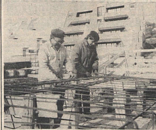
A 9-es jelű épület B-részeének első emelet feletti földemköszorvasalását végzik Ottó Ferenc és Major Gábor kőművesek.
