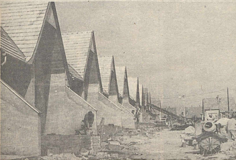
A bányauzem építői hamarosan befejezik a 9 OTP-s lakás külső munkáit
