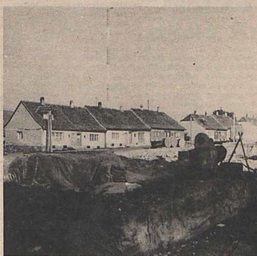
A kivitelező, a Baranya megyei Építőipari Vállalat szakemberei már az alapozást végzik a négy darab lakóházon. Fotó: Kóródi Gábor
