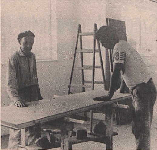
A Karbantartó Üzem dolgozói az utolsó simitásokat végzik a szilvási munkásklubban Fotó: Nemesi Árpád
