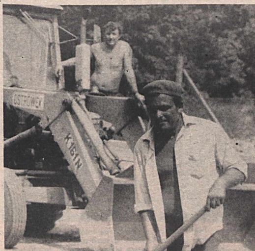
Rekkenő hőségben, a tűz napon folyik a Majakovszkij út óvoda udvarán a fogadósint alapozása.
