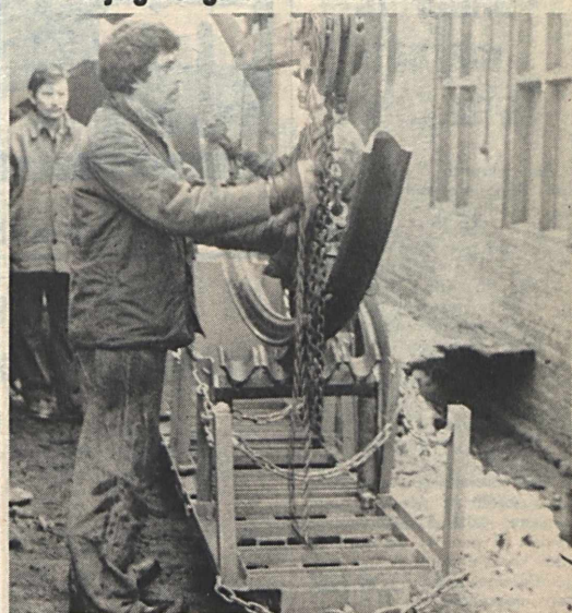
Az egységscsmagos szállításra szolgáló átrakó-szállítóberendezés.
