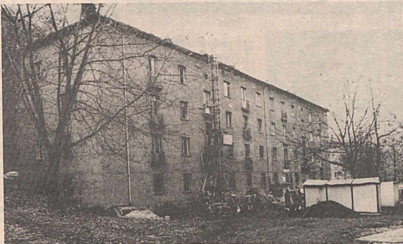
Befejezéséhez közeledik az Anna-aknai lakások belső felújítása
