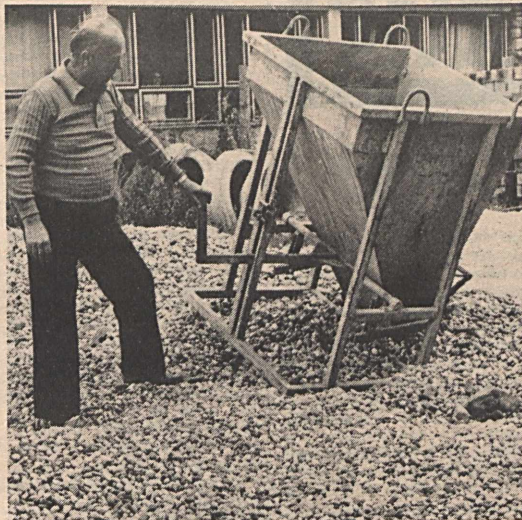
Tuma Imre újítása a képként látható betonszállító- és feladó konténer. Az előre elkészített zsalu ágyazatba daru segítségével emelik fel a betont tartalmazó konténert és minimális kézi erővel lehet az építő anyagot a zsaluba eresztani. Az újítás segítségével 3—4 ember munkáját lehet megtakarítani.
