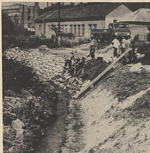
A Kaszánya-patak mederrendezési munkáit kezdte meg a sádsi Városgazdálkodási és Talajvédelmi Társulat. Az Ady Endre és a Kossuth Lajos út kereszteződésében a Dudás Lajos vezette szocialista brigád a partoldal kövezését végzi. Fotó: Beck Péter
