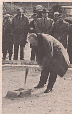
Az első csakányvágás a kijelölt akna helyén
