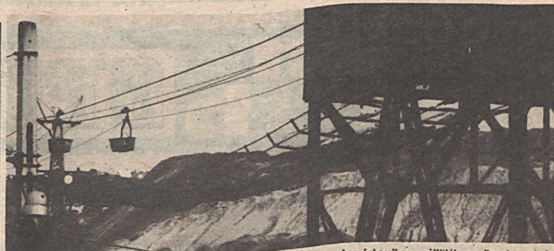
A bányüzemből a szén kőtélpályán önürítés vasúti kocskiban és tehervágókocsiban szállítják az üzembe, ahol bunkerokba ürítik a dúsításnak megfelelő arányban.
