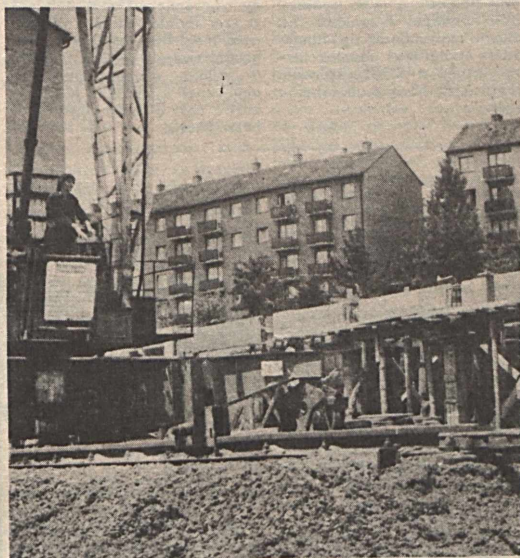
Komlón a Lenin téri ABC-áruház mellett megfelelő ütemben készül a tízezeres lakóépület. A kivitelezők eddig tudták tartani a határidőket. Az alapozási munkálatok befejezése után már hozzákezdtek a betonelemek beépítéséhez. Fotó: Kóródi Gábor
