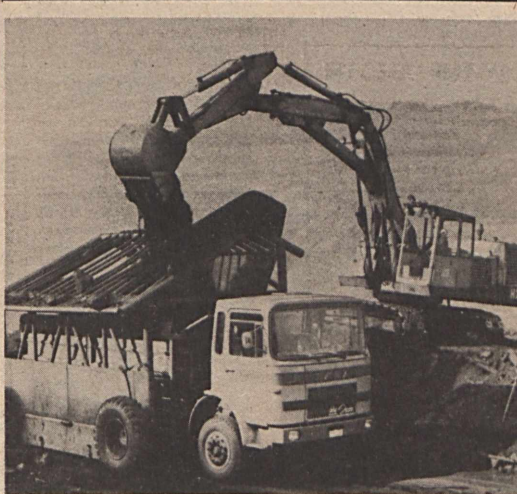
Traj Ferenc bányamester és Barta Ferenc művezető újítása a képkönnön látható és a Külfajti Üzemben működő mobil kivitelű palaválogató. A helyét változtatni tudó gép segítségével mintegy 30 százalékkal csökkenthető a fuvarok száma.
