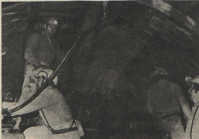
A Bányászati Akadémia Vállalat komlói üzemének Rajnics István vezette szocialista brigádja jelentős tevékenységet végez a Kossuth–IV-es aknai programban. A csapat az áltáró szintű kerülővágatban az utolsó előtti mező kiterését végzi — ezt követően kerül majd sor a lyukasításra. Beck Péter felvétele
