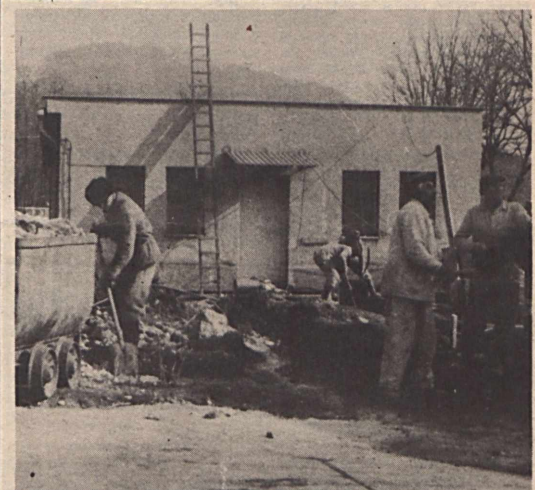
Béta-bányában a Karbantartó Üzem dolgozó január elején kezdte meg a bányamézőállomás átalakítását. A beruházás elsősorban azért szükséges, mert az üzem az újabb szint elérésével a gázkötésveszélyes üzemek besorolásába kerül. Ennek pedig követelménye, hogy
